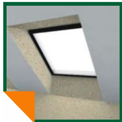
dokončenie podkrovia okien a opláštení
